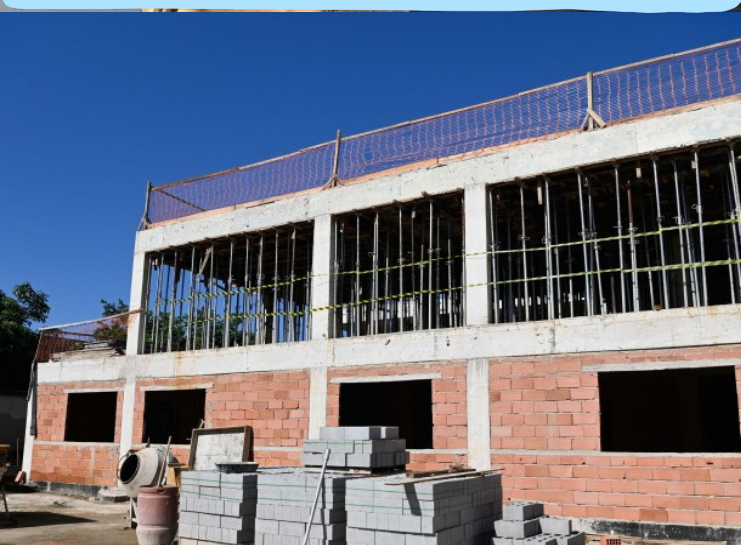
Obras da nova sede do CRAI
