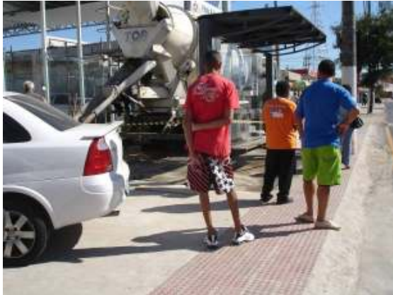
Figura 8 – Calçada em construção não segue a legislação – faixa de acesso de veículos ultrapassa o limite de 50% da testada do lote.
