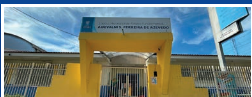
Climatização e reforma elétrica da Emef Asfa (Concluída)
