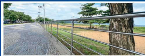
Instalação de parapeito na Praia de Camburi (Concluída)
