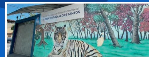
Climatização e reforma elétrica da Emef Elzira Vivacqua (Concluída)
