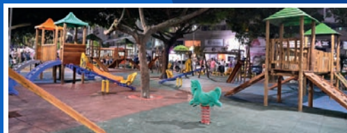
Melhorias na Praça Nilze Mendes, com a implantação do Parque Kids, cobertura da quadra de esportes e pavimentação do local (Concluída)
