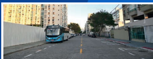
Pavimentação de 09 ruas de pavers, na região do antigo loteamento Santa Terezinha, e recuperação asfáltica de diversas ruas (Em execução)
