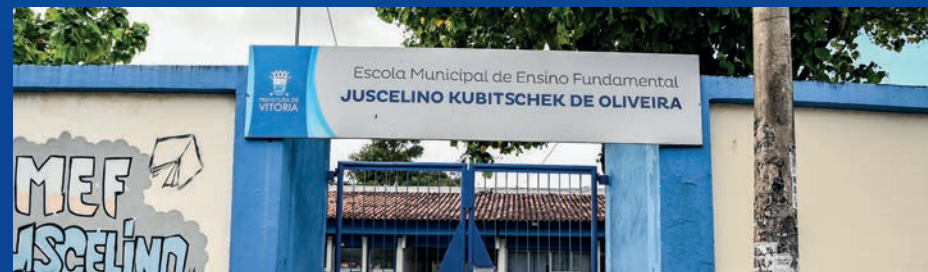
Reforma Elétrica da Emef Juscelino Kubitschek - Maria Ortiz (Concluída)
