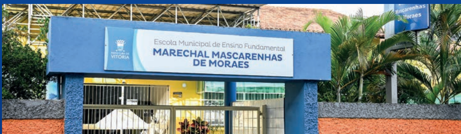
Reforma e instalações elétricas da Emef Marechal Mascarenhas de Moraes - Maria Ortiz (Concluída)
